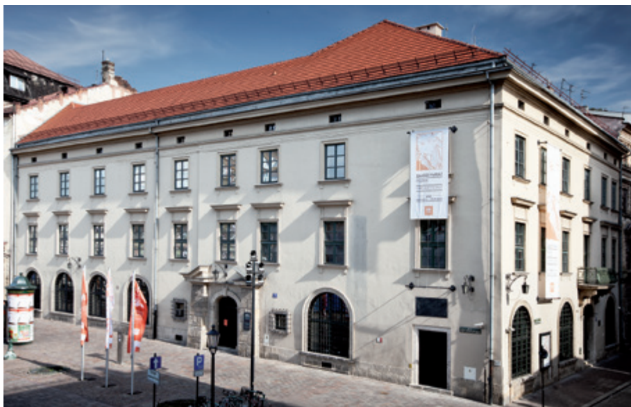
Kamienica Szolańskich od strony Placu Szczepańskiego – fasada po remoncie
