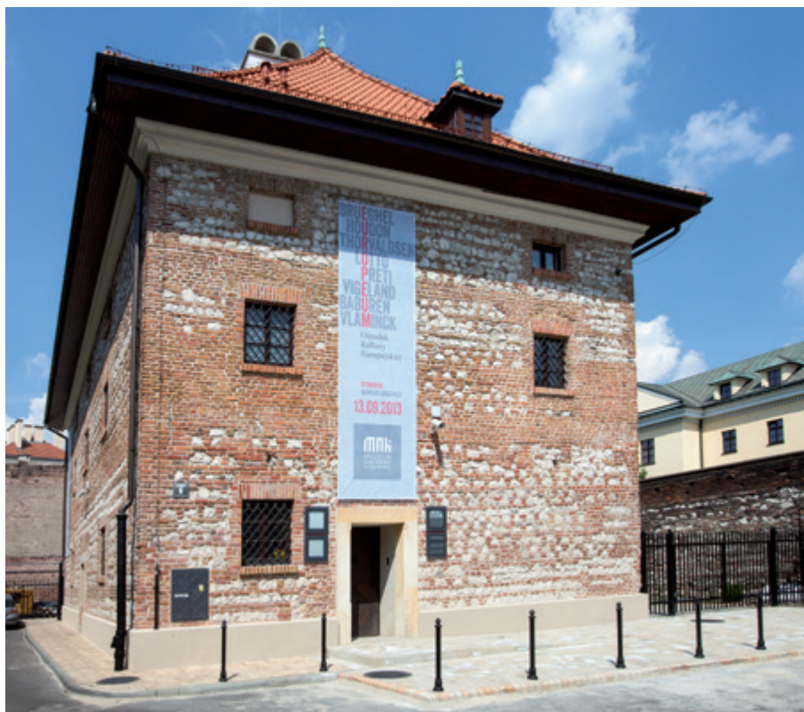
EUROPEUM – budynek dawnego Spichlerza po remoncie
