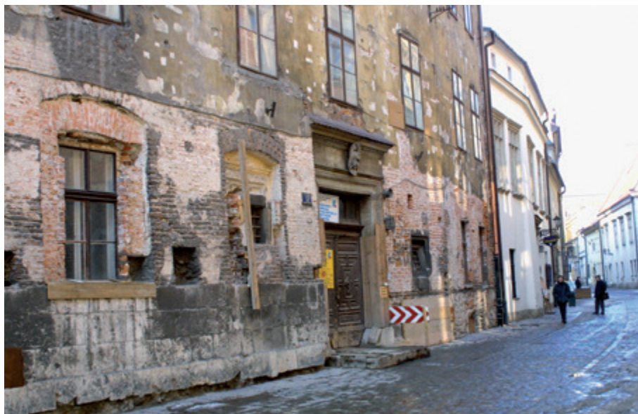
Pałac Ciołka – fasada przed remontem, fot. G. Kozakiewicz
