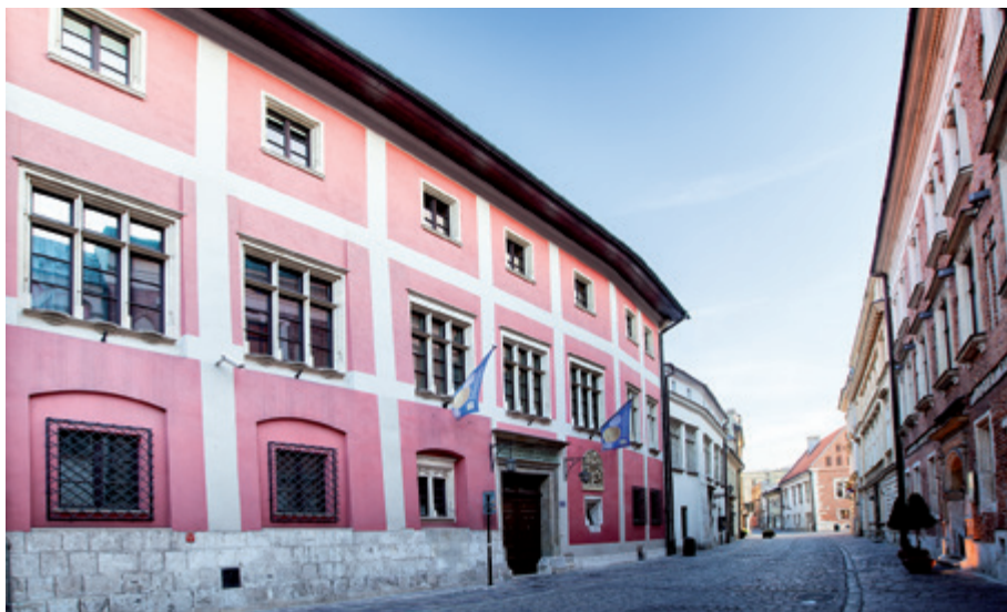
Pałac Ciołka – fasada po remoncie
