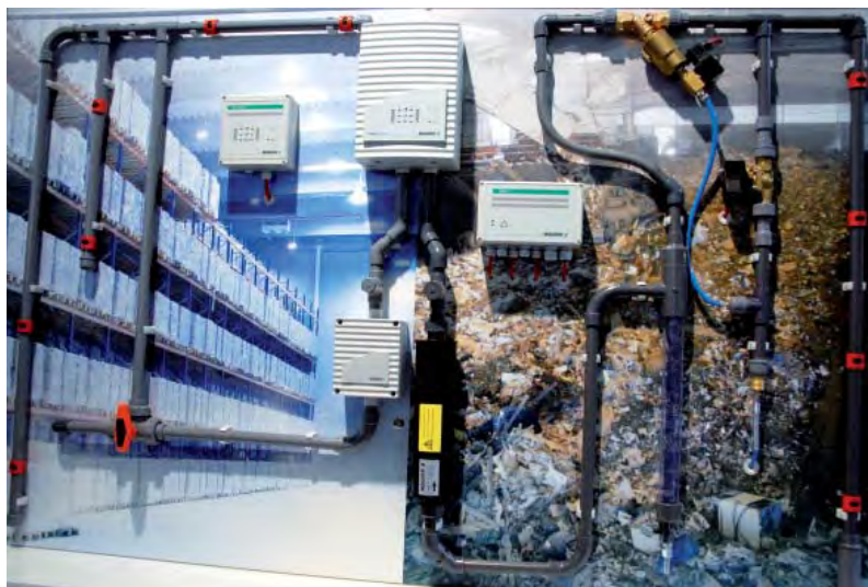
Przykładowa struktura działającej instalacji zawierającej dodatkowe komponenty służące zachowaniu drożności orurowania oraz zwiększeniu precyzji detekcji (fot. archiwum NIMOZ) 4
