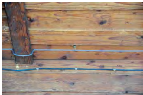
Dysza spiralna i rurka detekcyjna (fot. archiwum NIMOZ)
