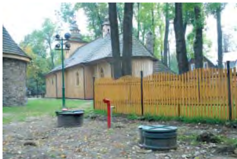
Widoczne elementy zbiornika i komory (fot. autor)
