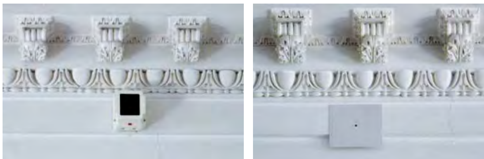
Zastosowanie w praktyce tradycyjnych optycznych liniowych czujek dymu. Patrząc od lewej: nadajnik i lustro (pryzmat) (fot. archiwum NIMOZ)
