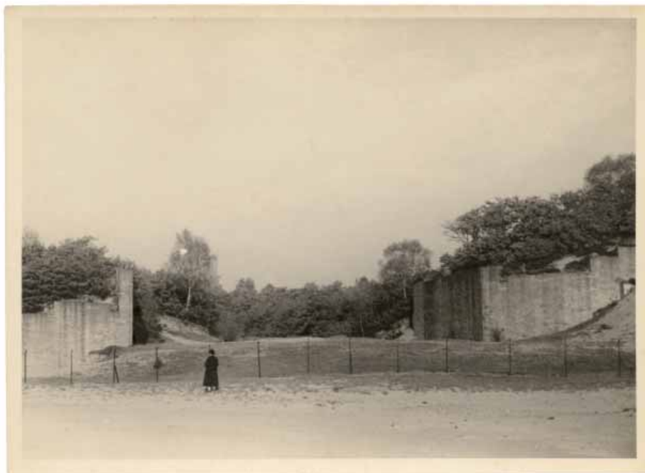
Helene Kröller-Müller przy fundamentach „wielkiego muzeum”, po wstrzymaniu prac budowlanych w 1922 r., © Kröller-Müller Museum
