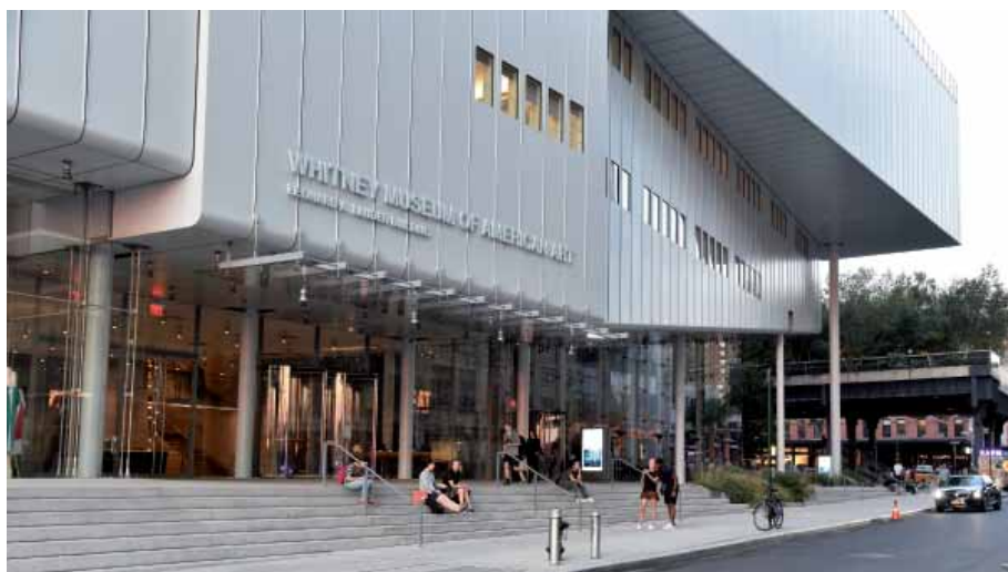
Widok na wejście główne, po prawej stronie widoczny początek parku High Line, fot. autor
