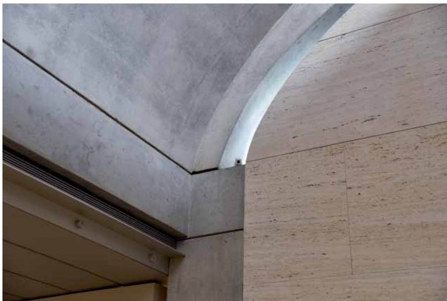
Detal konstrukcji stropu – betonowe słupy i belki podtrzymują beczkowate sklepienia, wzdłuż belek rozprawa- dzona jest instalacja klimatyzacyjna, fot. autor
