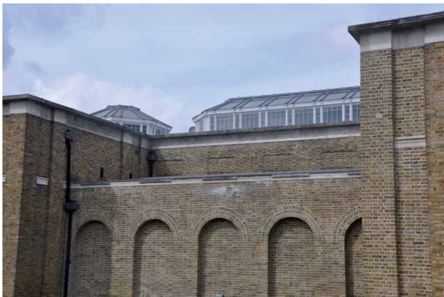
Świetliki dachowe i surowe detale ceglanej elewacji, fot. autor
