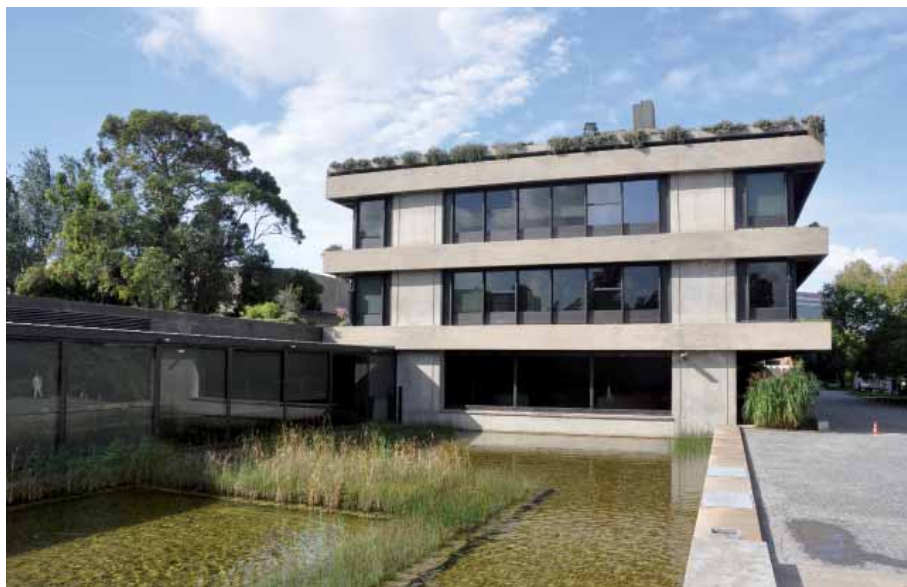
Budynek Fundacji Calouste Gulbenkiana, fot. autor
