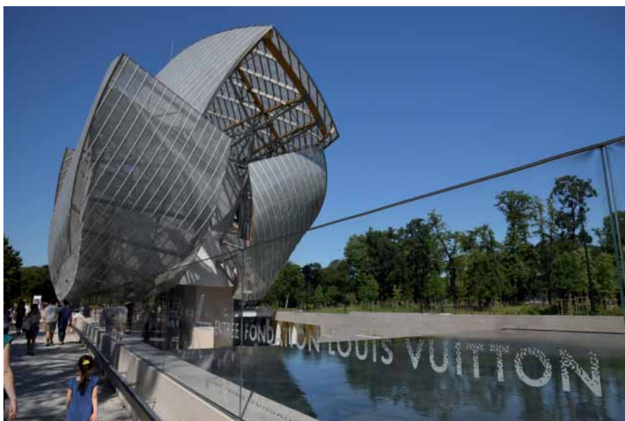
Fondation Louis Vuitton w Paryżu, proj. Frank Gehry, 2014, fot. autor
