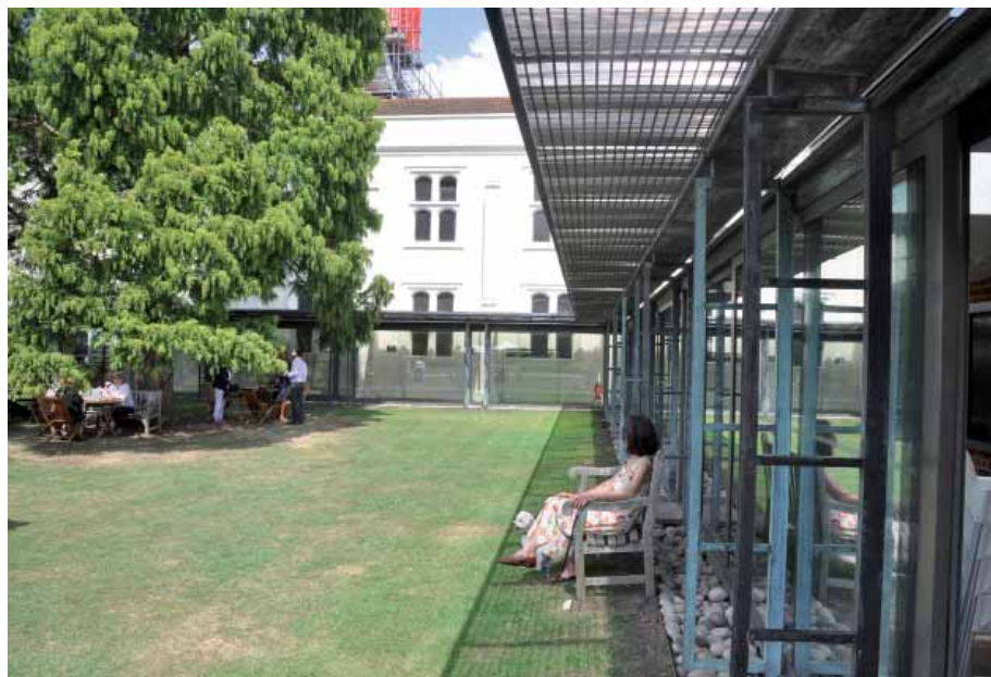
Przeszklone krużganki łączące galerię z pawilonem wejściowym, w głębi zabudowania Dulwich Old College i wieża The Almshouses Christ's Chapel, fot. autor
