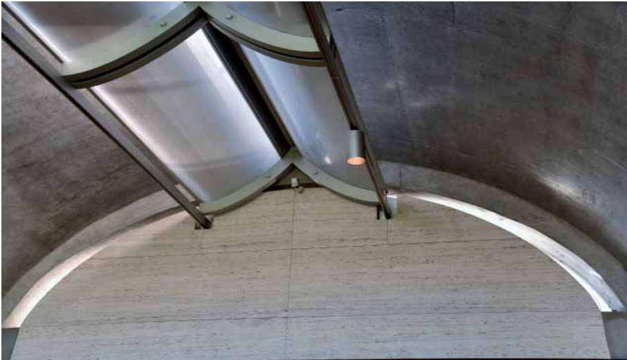
Podwieszony pod szczytem rozciągniętego sklepienia aluminiowy reflektor odbijający i rozpraszający światło słoneczne, fot. autor
