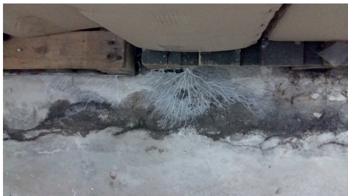
Ryc. 14. (A) Wzrost gnilicy mózgowej ( Coniophora puteana ) na betonowej posadzce; przyczyna: wprowadzenie do magazynu w piwnicy zainfekowanych palet i wysoka wilgotność w pomieszczeniu. (B) Wzrost grzybów pleśniowych w bibliotece; przyczyna: półki wykonane z niedosuszonego, niezabezpieczonego drewna w magazynie na poddaszu. Fot. M. Dyda
