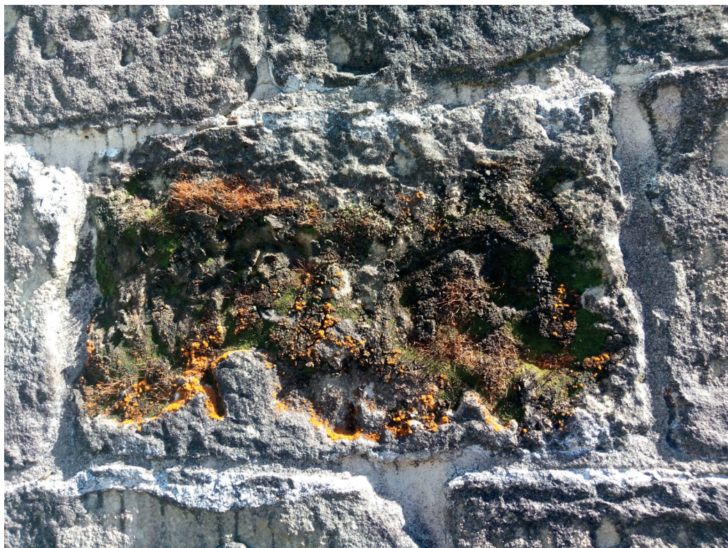
Ryc. 5. Biodeterioracja zabytkowego kamienia. Fragment muru na wzgórzu Monte Urgull w San Sebastián w północnej Hiszpanii. Fot. M. Dyda
