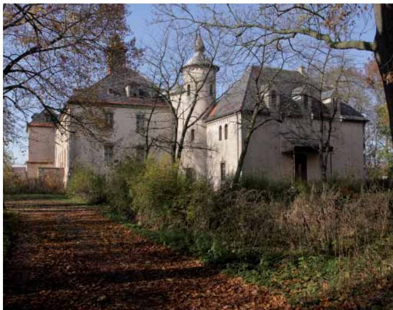
3. Pałac w Gaju Małym, stan obecny, fot. M. Mencfel
