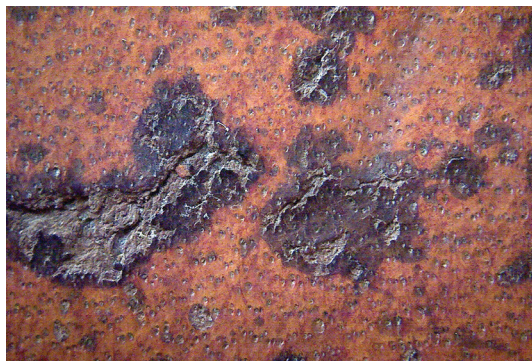
Fot. 33. Spękania i uszkodzenia lica skóry w miejscach pokrytych bejcą.
