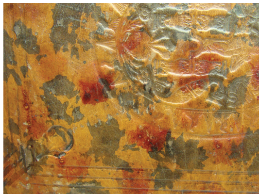
Fot. 9. Marmurek dwukolorowy wykonany gąbką.
