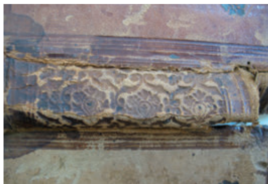
Fot. 22. Zniszczenia opraw: pęknięcia, złamanie grzbietu, ubytki, zacieki, przetarcia lica, wyblaknięcie przedniej okładziny (znajdującej się u dołu)
