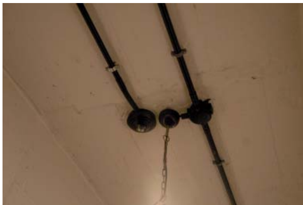
Fot. 7, 8. Maskowanie, upodobnianie przewodów i czujek systemu sygnalizacji pożarowej do istniejących instalacji zabytkowych w budynku starego browaru (od lewej) oraz montaż zewnętrznej bariery podczerwieni systemu sygnalizacji włamania i napadu imitujący rolety w budynku na terenie kopalni. Deutsches Technikmuseum Berlin, LWL-Industriemuseum Dortmund
