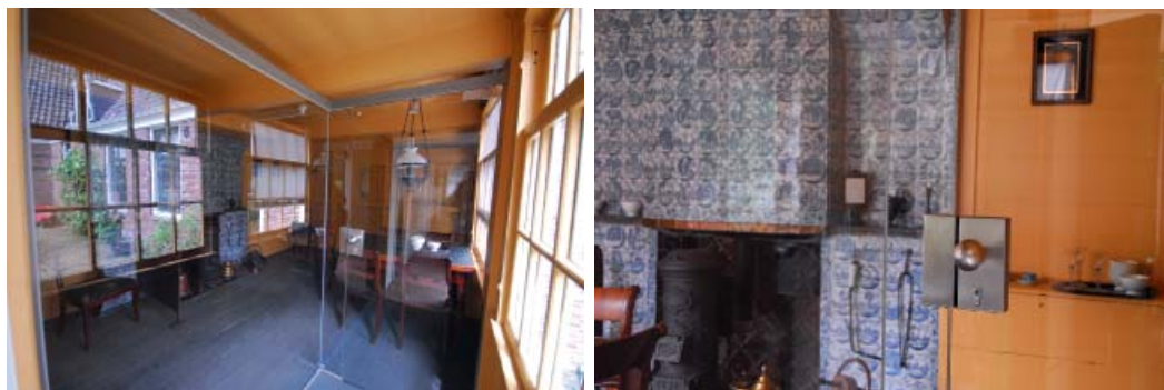
Przykłady zastosowania wygradzeń wykonanych ze szkła zespolonego oraz plexi o grubości 12 mm
