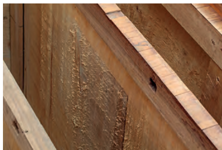
il. 11. Ślady po cięciu piłą traka. Przegroda pomiędzy szufladami klasycystycznej komody mediolańskiej z końca XVIII w.
