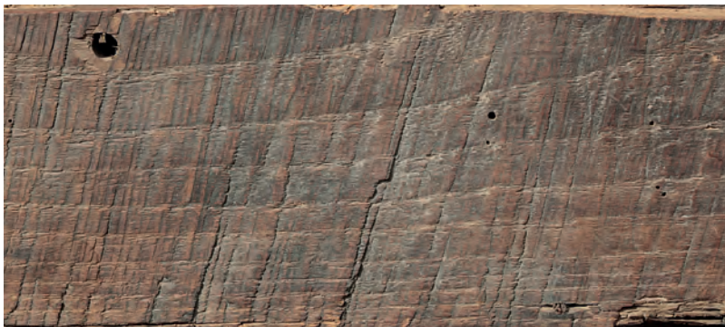
il. 13. Ślady ręcznego piłowania.
