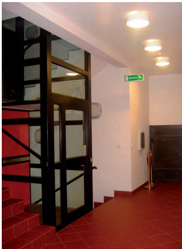
7. Winda wewnątrz nowej klatki schodowej
