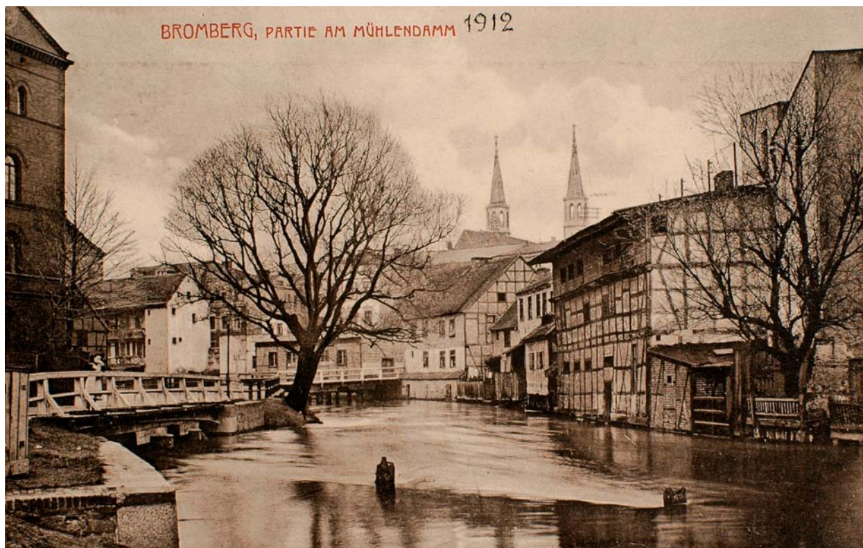
1. Młynówka – widok w kierunku mostu Młyńskiego (z lewej most nad wlotem międzywodzia), 1912
