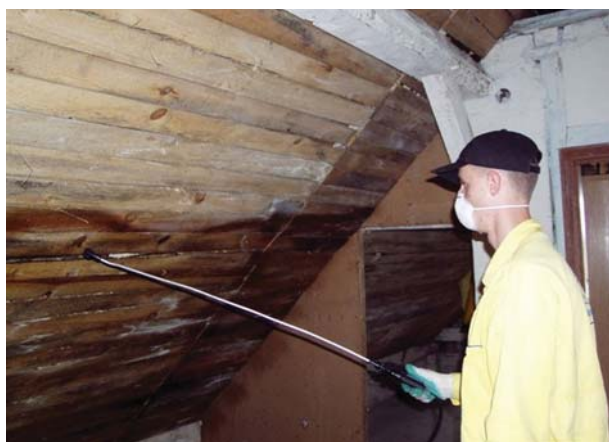
4. i 5. Impregnacja strychu magazynu
