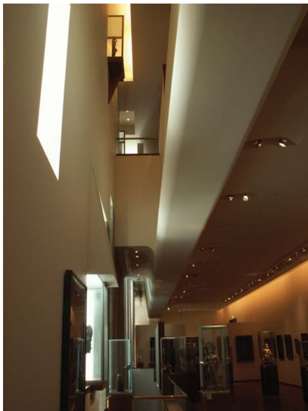
12. Musée Guimet, świetlne szczeliny oświetlają dolne kondygnacje i ułatwiają orientację
