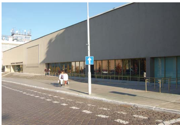
3. Nowe skrzydło głównego budynku, elewacja zachodnia wzdłuż Alei Marcinkowskiego
