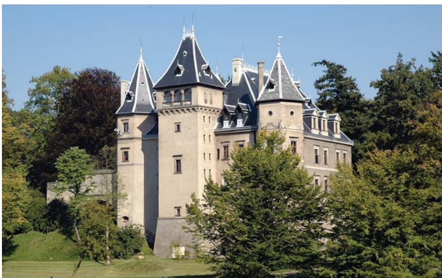
1. Widok Zamku w Gołuchowie, stan obecny
