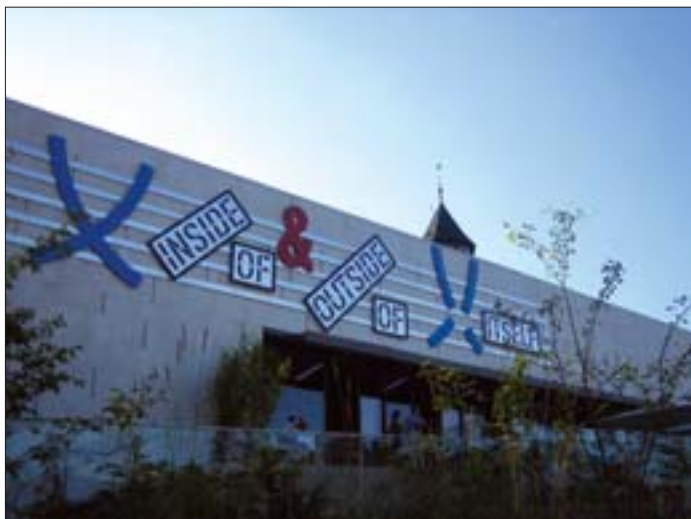
5. Wewnątrz tegoż zewnątrz, fasada Museum der Moderne w Salzburgu, 2006
