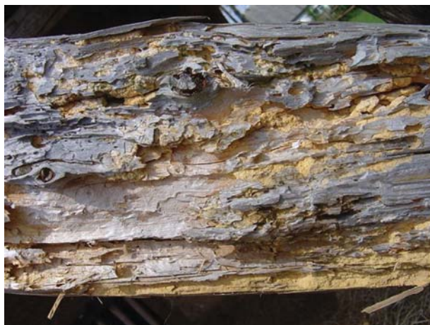
2. Zniszczenia spowodowane przez spuszczela
