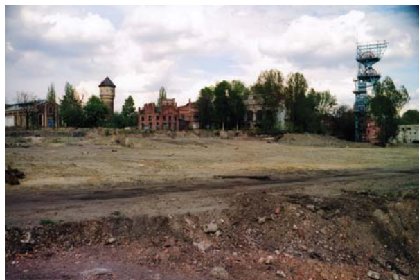
4. Widok obiektów przemysłowych byłej KWK „Katowice”, od 31 12 2004 własność Muzeum Śląskiego
