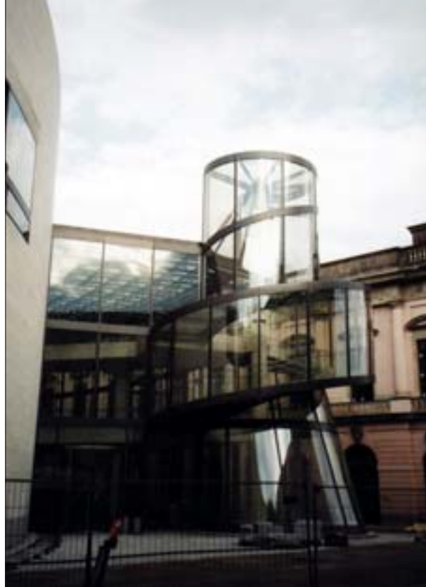
4. Muzeum Historyczne w Berlinie. Szklana trzykondygnacyjna hala przylega do historycznego budynku, łączy się pod ziemią z Arsenalem
