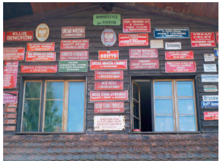
3. Stare tablice urzędowe zawieszono na fasadzie budynku z pokojami noclegowymi
