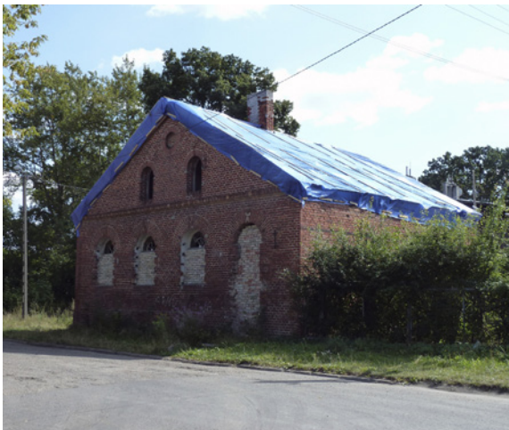
3. Trybunator wschodni, stan po zabezpieczeniu, przyszła siedziba instytucji Wzgórze Kreatywności Kulturowej „Trybunator”
