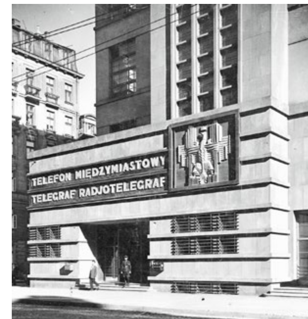
↑ 179. Gmach Głównego Urzędu Telekomunikacyjnego przy ul. Nowogrodzkiej 45 w Warszawie, projekt Julian Puterman-Sadłowski. Nad wejściem widoczny orzeł zaprojektowany przez Jana Golińskiego, lata trzydzieste XX w., Narodowe Archiwum Cyfrowe
